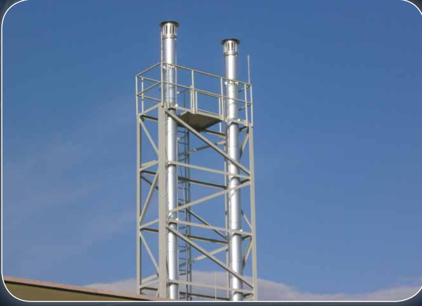
Çift Cidarlı Kontsrüksiyonlu Doğalgaz Bacası - Havelsan - Merzifon Amasya
