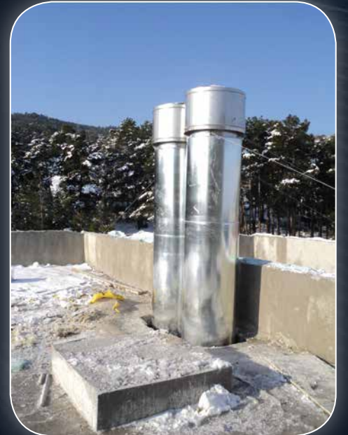
Denizli Acıpayam Hastanesi Katı Yakıtlı Baca Uygulaması
