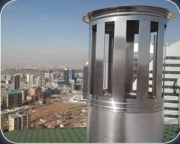
KONYA YOLU MEMORİAL HASTANESİ DOĞALGAZLI BACA UYGULAMASI
