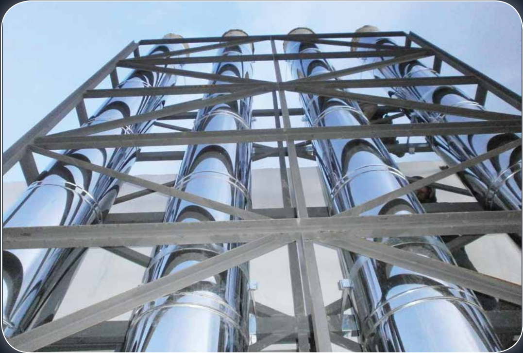
Dhmi Esenboğa Havaalanı Hangarları Baca Uygulaması - Ankara
