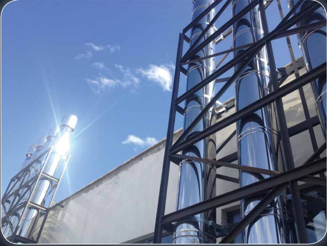
Dhmi Esenboğa Havaalanı Hangarları Baca Uygulaması - Ankara
