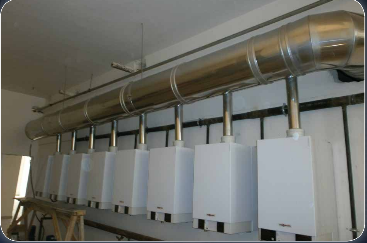
Oasis Fabrika Kaskad Baca Uygulaması - Kazan Ankara
